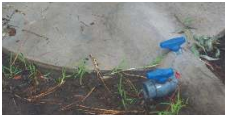
Llaves esclusa para el redireccionamiento de líquidos.
