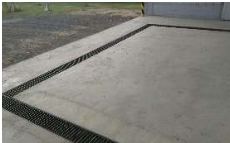
Alcantarillas con pendientes para el derrame de líquidos.
